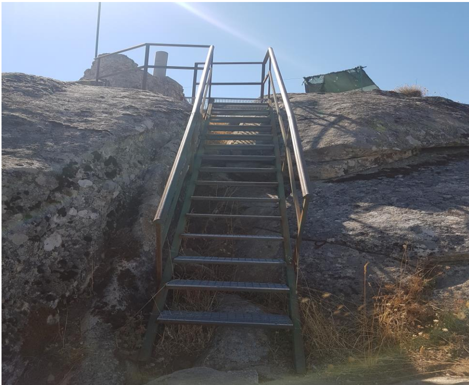
FOTO 7. SEGUNDO TRAMO DE ESCALERAS. ACCESO A LA CIMA.
